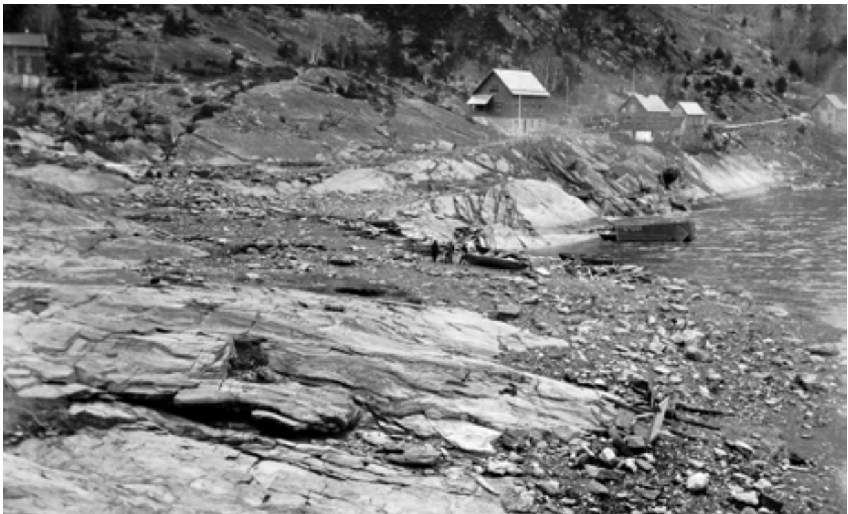
FIGUR 8. Bebyggelsen i Fjørå i Tafjord ble knust av en flodbølge etter fjellskredet fra Langhammaren i 1934. Bildet øverst viser bebyggelsen før fjellskredet. Foto Astor Furseths fotoarkiv.
