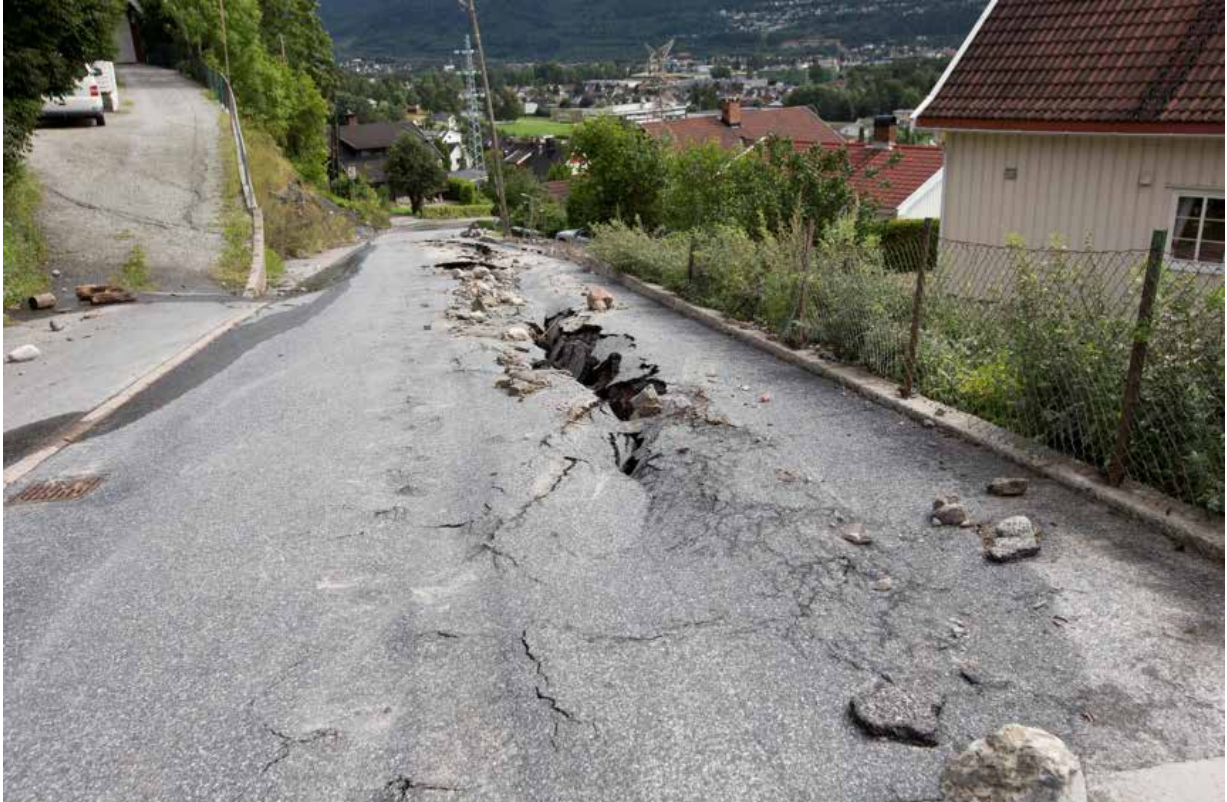
Krokstadelva i Nedre Eiker etter ekstremværet «Frida» i 2012. Foto: Terje Bendiksby/NTB Scanpix.
